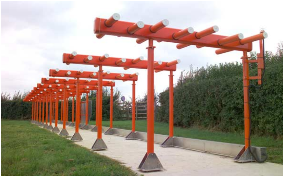
Réseau d'antennes de type « log périodique » d'un LOCALIZER
