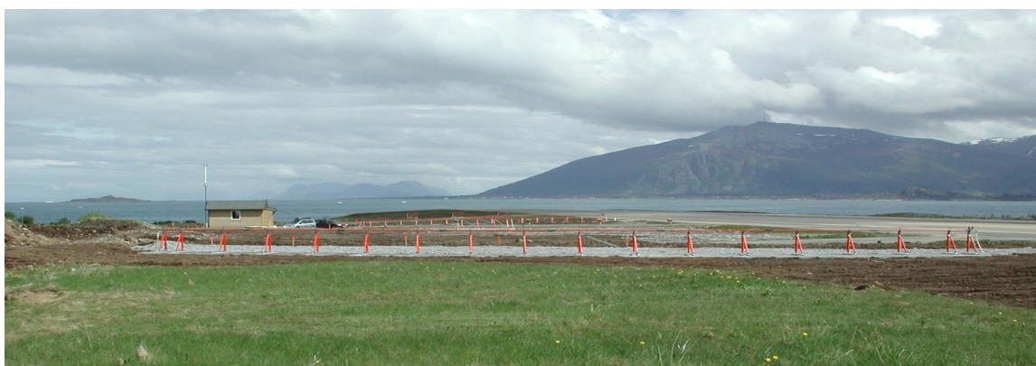
Installation d'un glideslope endfire system à Vigra, en Norvège.
