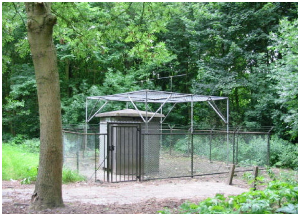
Installation au sol d'un OUT MARKER
